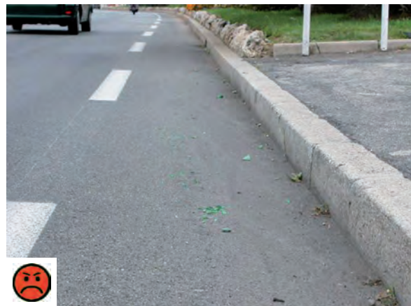
Mauvais entretien rendant la bande impraticable
